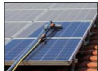
Zonnepaneel reiniging
